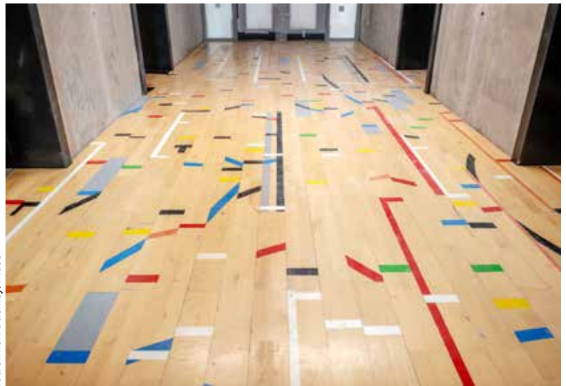
Podłoga w holach windowych z drewna odzyskanego z siłowni
